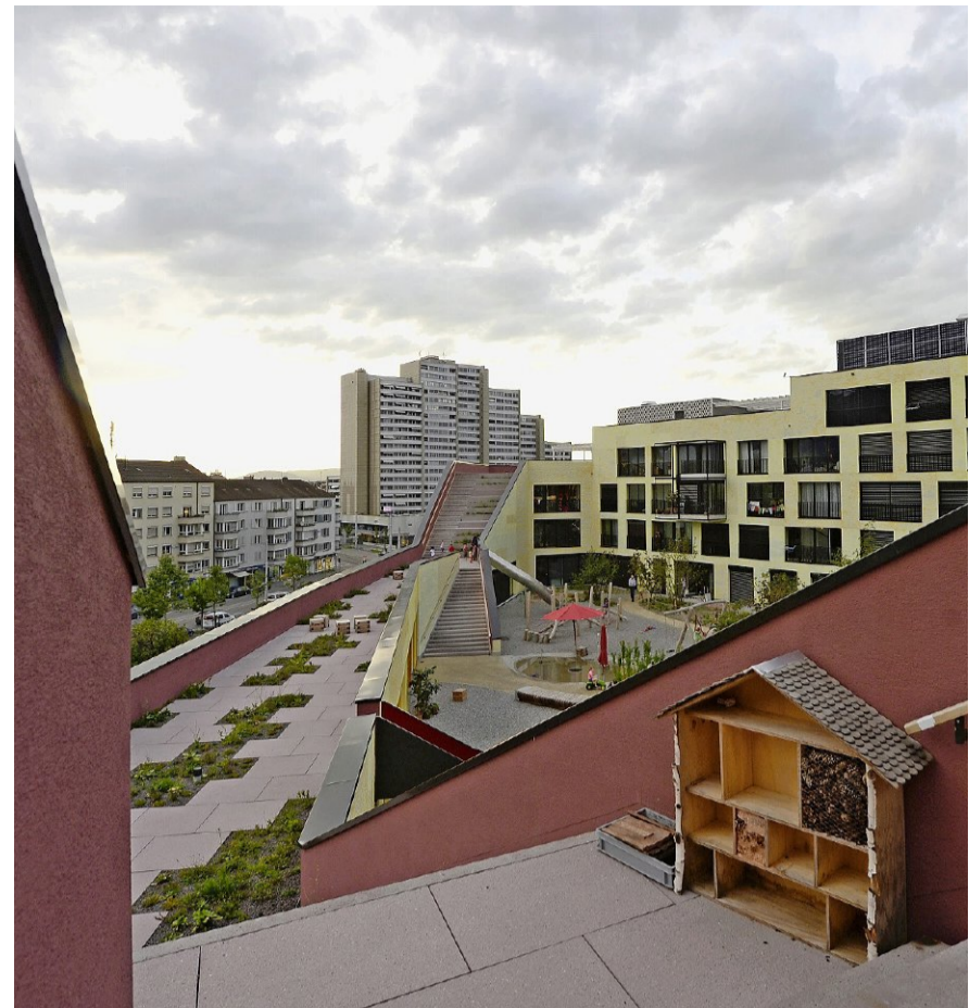
Terrasse und Innenhof über der Trameinstellhalle. Foto: Doris Fanconi
